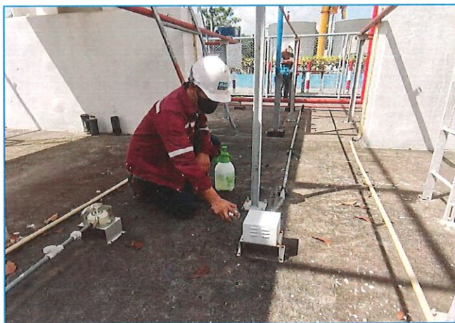
รูปการทดสอบระบบ GAS LEAK DETECTOR
